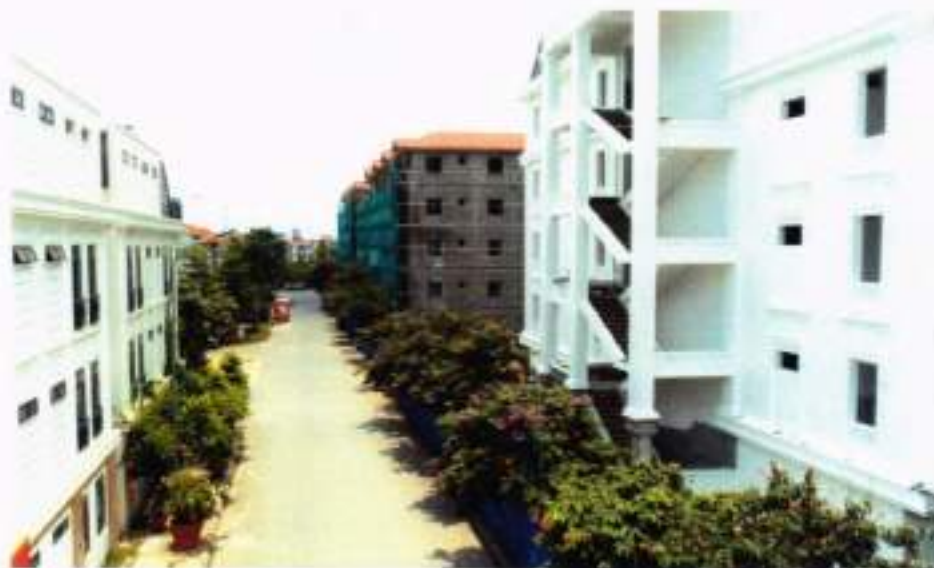
Cận cảnh các chung cư đang được dân hoàn thiện
