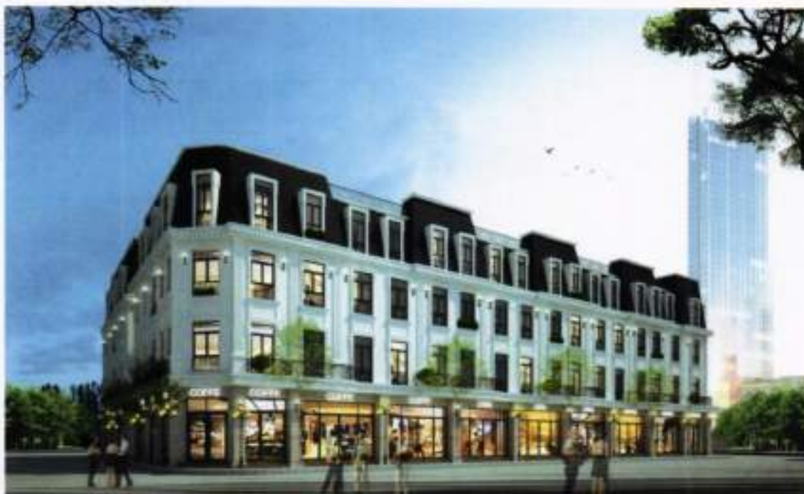
Dãy shophouse thấp tầng của dự án
